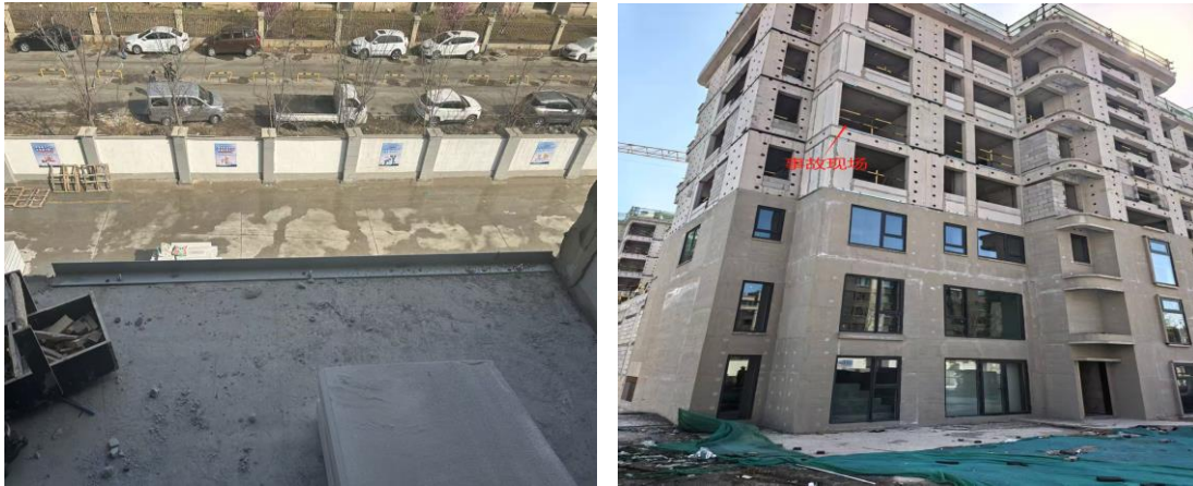
事故发生地实景
